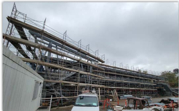
AVANCE EN LA FACHADA SUR DEL EDIFICIO H
