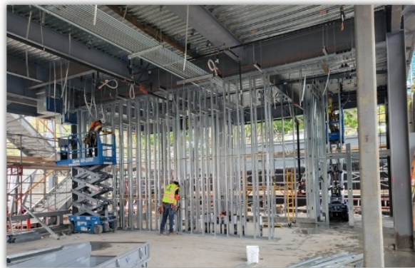
ENMARCADO DE PAREDES PARA EL FUTURO CUARTO DE ALMACENAMIENTO Y TELECOMUNICACIONES PARE EL AULA A.
